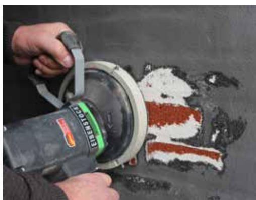
Fastsiddende plast- og oliemaling brydes/fjernes mekanisk for at undgå dampspærre midt i muren. Anvend facadefræser eller lign.
