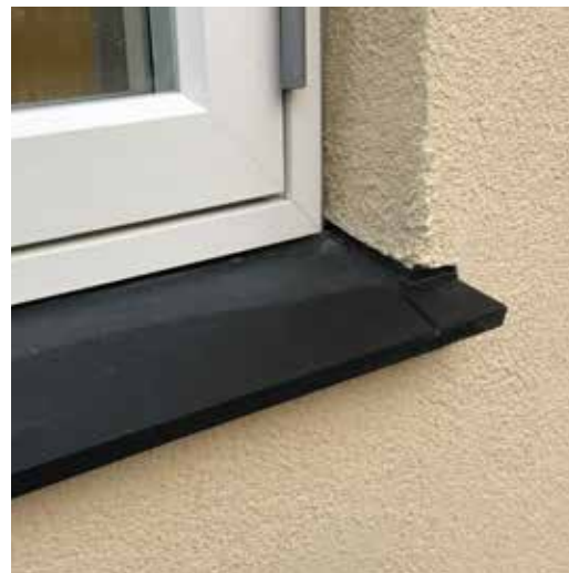
Færdigmonteret sålbænk afsluttet med fuger mod profilen.
