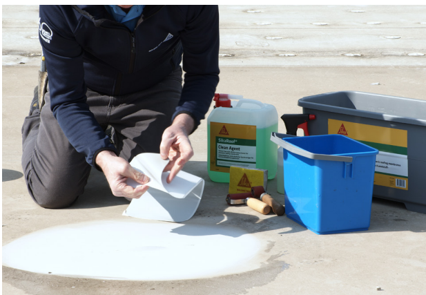
7. Fjern aftræksforingen med fingeraftrækket.
