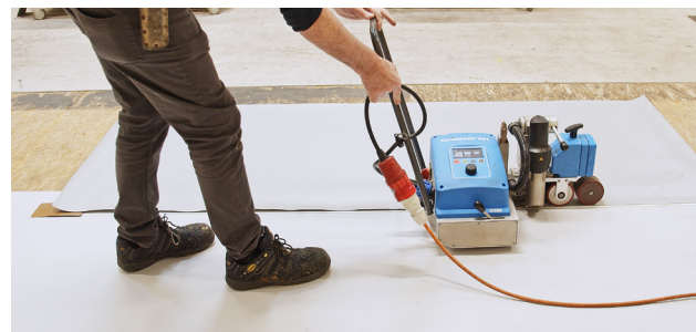
4. Automatisk varmluftsvejsning af Sarnafil® FPO-membran på SikaRoof® Multitape.
