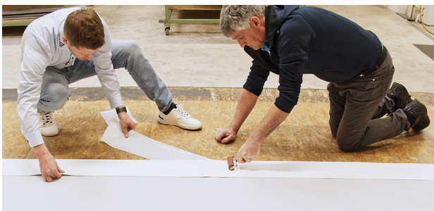
1. Montering af SikaRoof® Multitape oven på eksisterende syntetisk eller bituminøs tagdækning.
