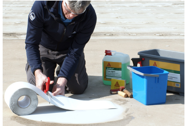
6. Skær SikaRoof® Multitape til i den ønskede længde.
