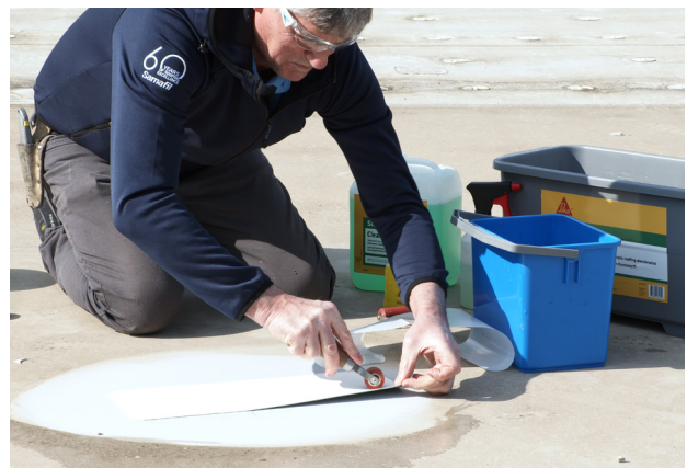
8. Fastgørelse af SikaRoof® Multitape med trykrulle.
