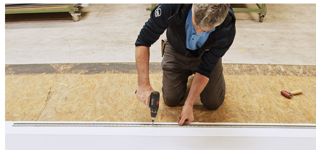
2. Montering af Sarnabar®-fastgørelsesprofil med Sarnafast®-fastgørelseselementer og Sarnafil® T-svejsesor.
