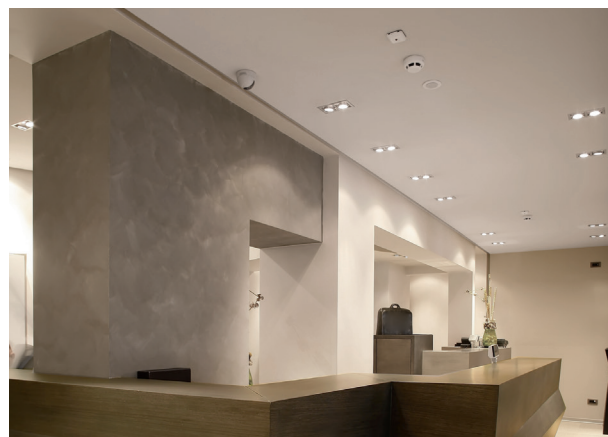
En rå detalje med microcement på væggen
