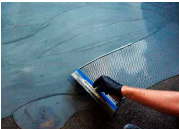
Materialet fordeles ensartet med en savtakket spartel eller lagindikator.
