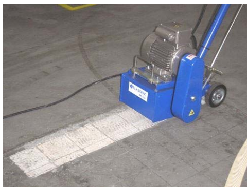
Fræsning af betonen
