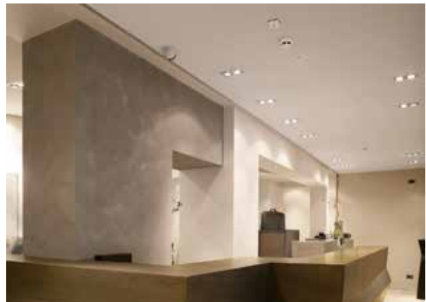
En rå detalje med microcement på væggen
