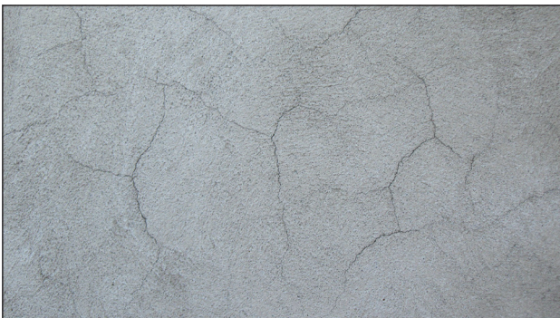
Eksempel på kosmetiske overfladerevner.
