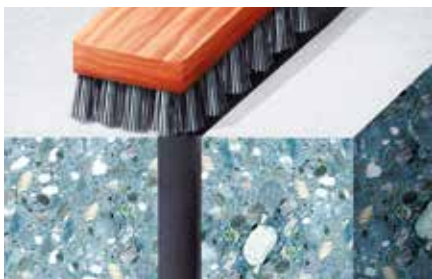
Klargøring af fuge før fugning
