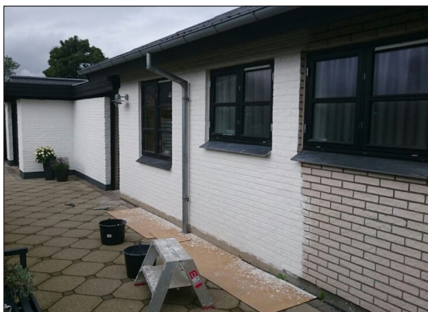
Igangværende påføring med Skalcem® 1000.
