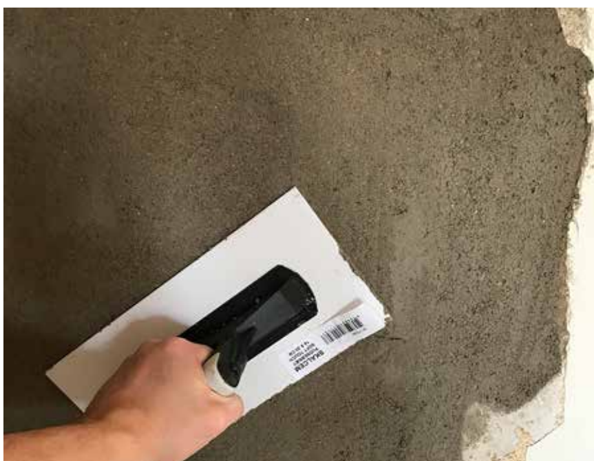
Skader på muren repareres inden selve fugtsikringen påbegyndes.
