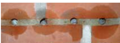
De kemiske fugtmembraner aktiveres ved kontakt med fugt, og fordeler sig inde i muren, hvor fugten er tilstede. Dermed dannes en effektiv, fugtspærrende barriere.
