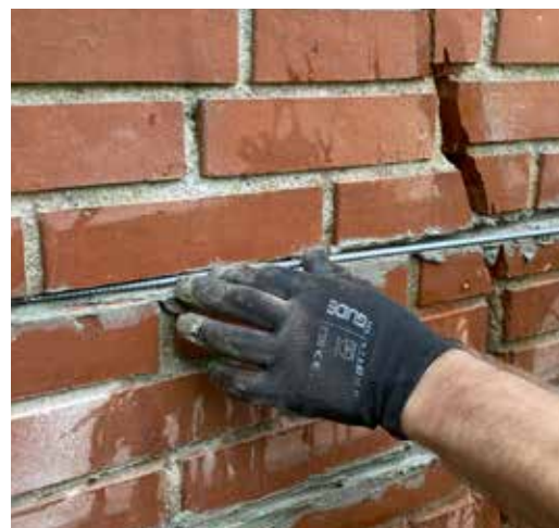
Eventuelle sætningsrevner udbedres med Skalflex® Armeringssystem
