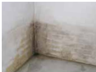
Eksempel på opstigende grundfugt indvendig i kælder.
