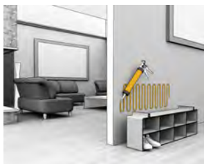
Limning af skabe på vægge.
